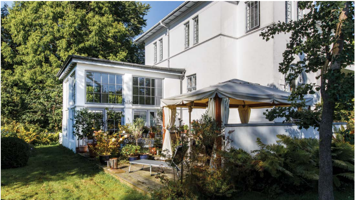
Tilbygning til villa beliggende i Virum tegnet af Dennis Rosenfeldt Petersen
