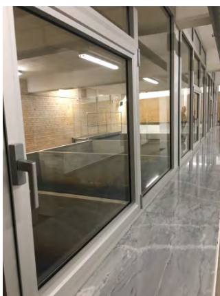
Figur 5: Åbne sandfiltre
