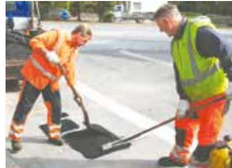
Foto: Reparation af slaghuller
