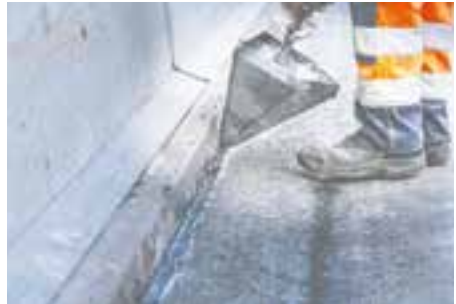
Foto: Munch, reparation af elastisk fuge
