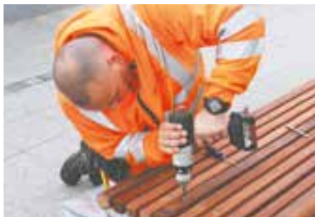
Foto: Reparation af bænk, Holte Stationsvej, Holte
