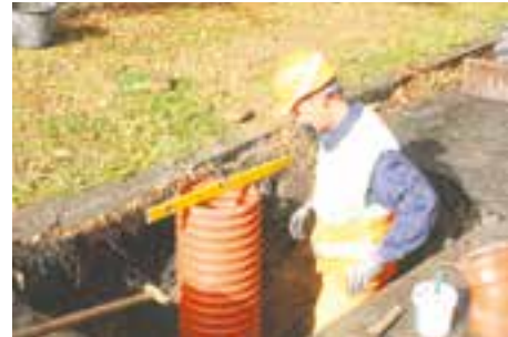
Foto: Udskiftning af vejbrønd, Mosevangen, Birkerød
