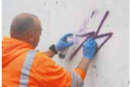
Foto: Afrensning af graffiti, tunnelvæg
