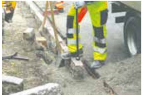
Foto: Reparation af kantning
