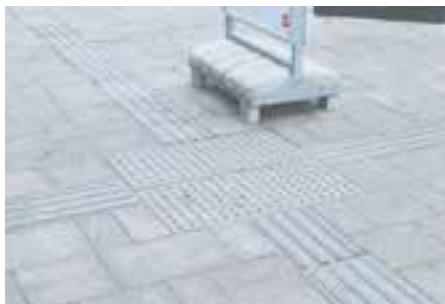
Foto: Granitfliser med ledelinjer og taktifliser, Holte Trafikplads, Holte
