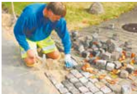
Foto: Reparation af granitbelægning
