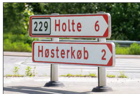
Ikke-lakeret eftergivelig Milewide stander med national vejvisning, udenfor bycentre.
