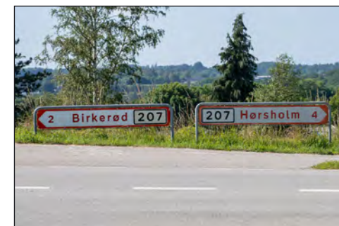
Ikke-lakeret galvaniseret standard stander med national vejvisning, udenfor bycentre.
