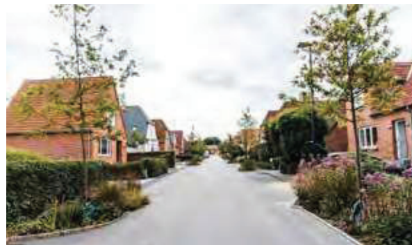
På denne 'klimavej' i Middelfart har anlæg af regnbede forskønnet en bred, lige vej – og sænket hastigheden.
