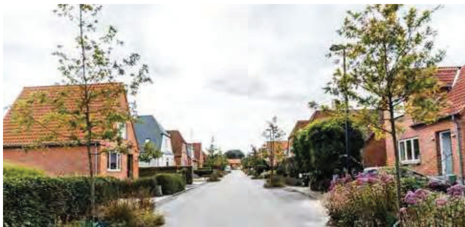
Eksempel: Regnbed på en villavej i Middelfart
