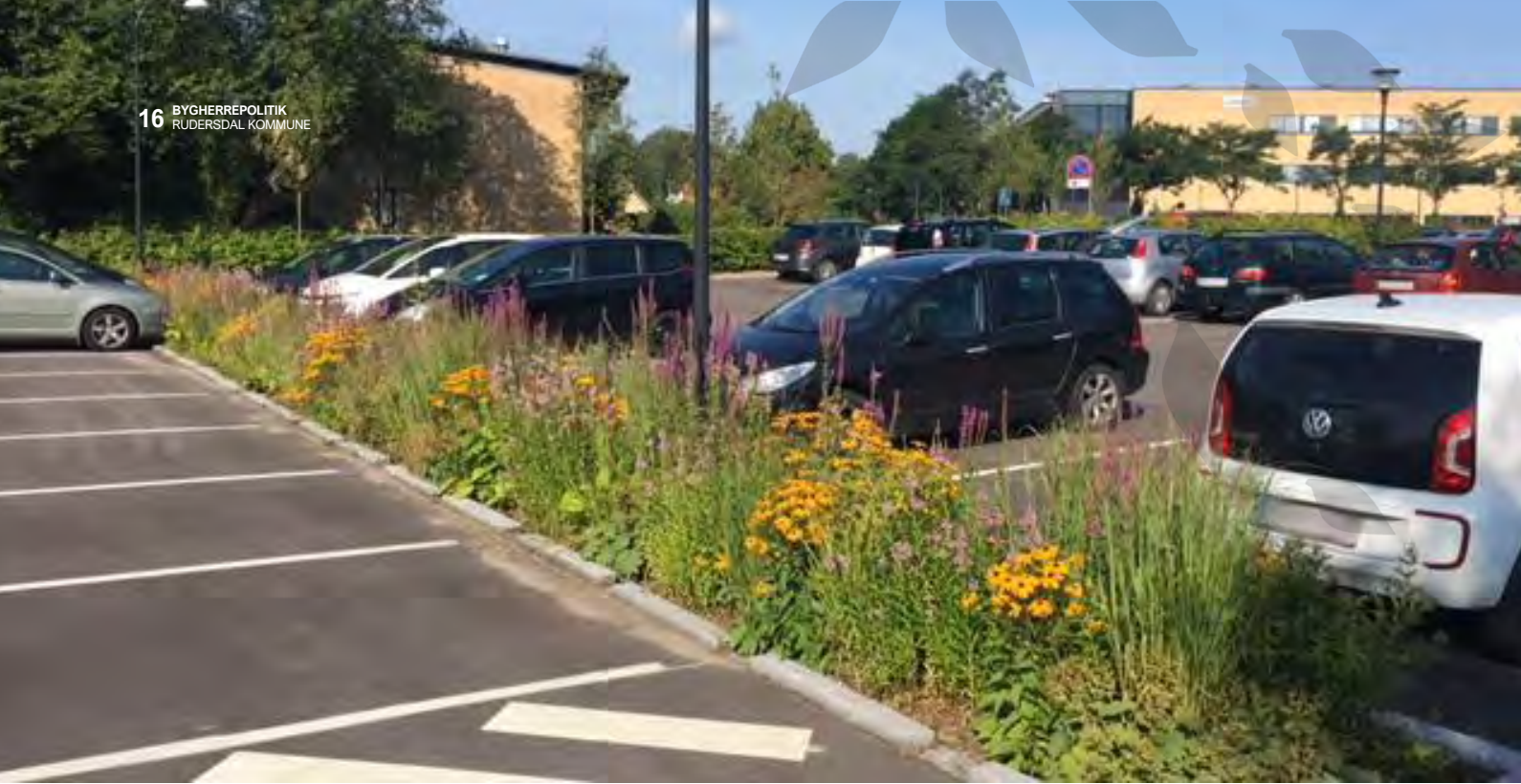
Figur 23 – LAR-anlæg ved Gasværksvej, Birkerød
