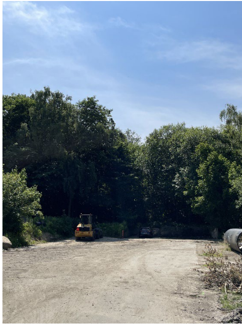
Figur 2 - Byggeplads set fra Nord
