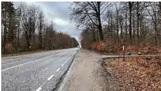
Billede 3 Kantbane og busstop Hørsholm Kongevej
