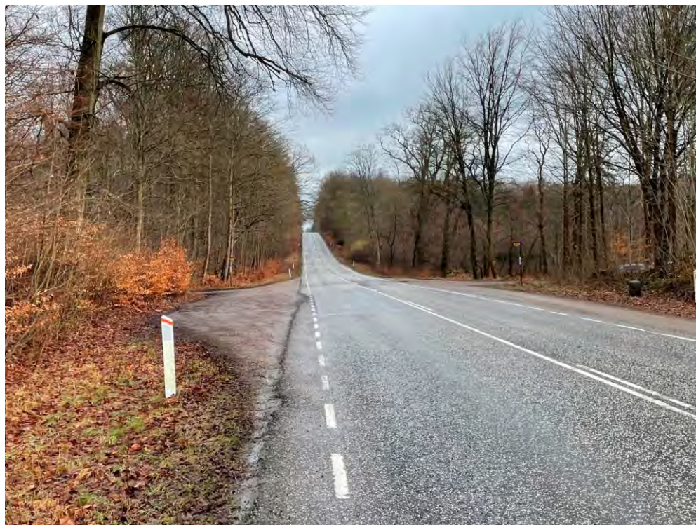
Figur 11-10. Foto fra st. 2 +200. Aktuelle forhold.
