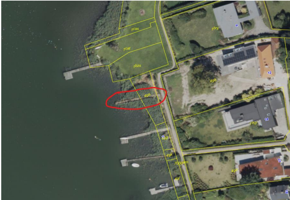
Foto 1. Det markerede område angiver den eksisterende gamle bro, som søges udskiftet.
