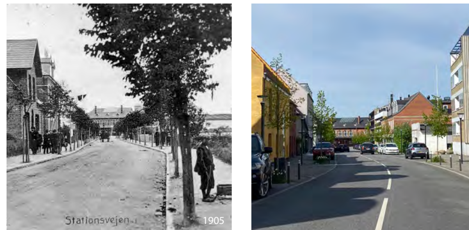
Foto: Det gamle Vedbæk
