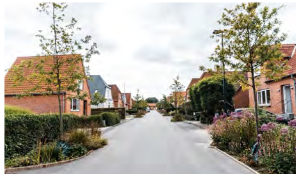
På denne 'klimavej' i Middelfart har anlæg af regnbede forskønnet en bred, lige vej – og sænket hastigheden.
