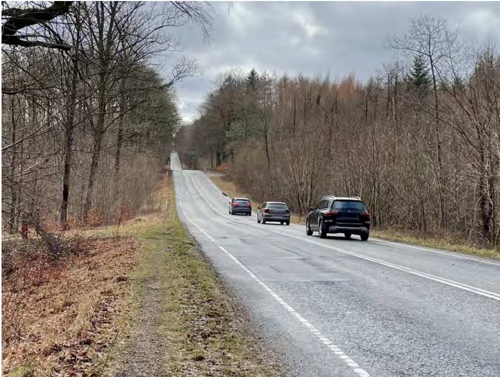
Figur 11-8. Foto fra st. 1 +750. Aktuelle forhold.
