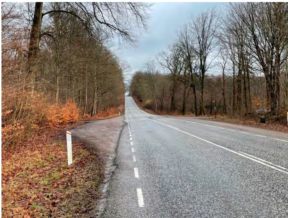
Figur 11-10. Foto fra st. 2 +200. Aktuelle forhold.
