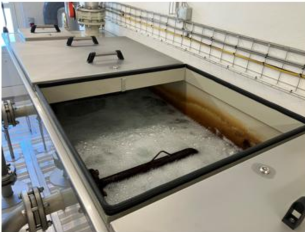
Figur 3 - Iltningskammer åbent
