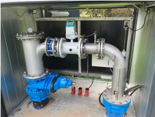
Figur 27 – Boring 10 – Forside med pumper
