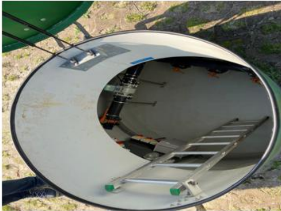
Figur 17 – Boring 1 – Nedgang til boring
