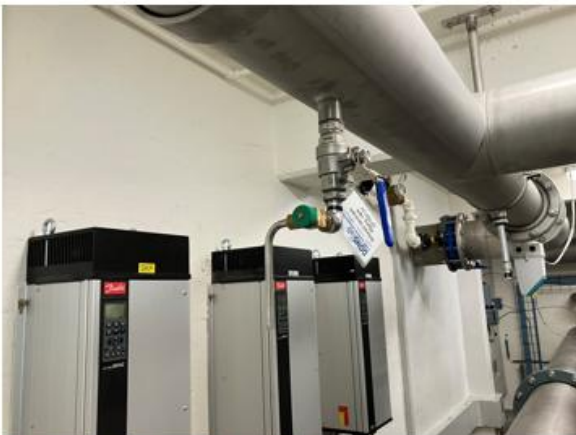
Figur 9 – Prøvehane efter UV-anlæg
