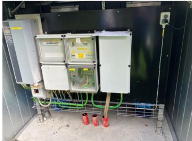
Figur 28 – Boring 10 – Elektriciteten placeret på bagsiden
