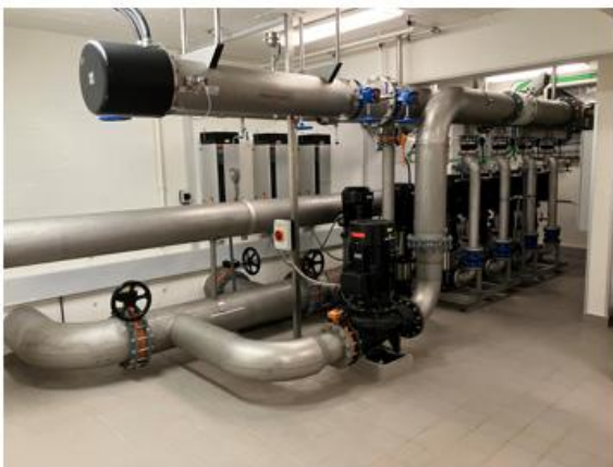
Figur 7 – Rentvandspumper, UV-anlæg mm.
