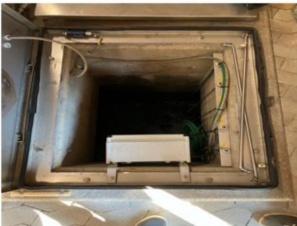
Figur 13 – Nedgang til rentvandstank - Åben
