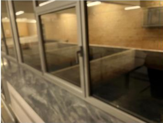
Figur 5 – Åbne sandfiltre
