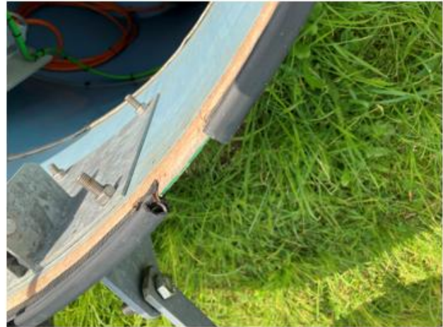
Figur 30 – Boring 8 – Knækket gummiliste
