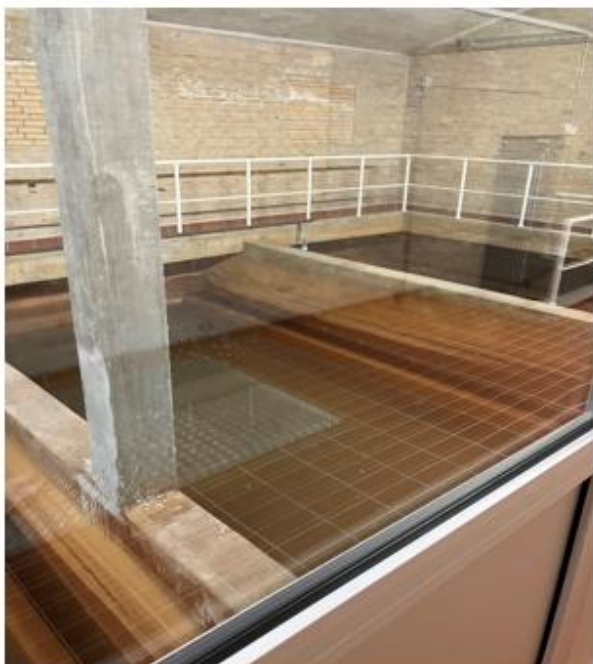
Figur 1 – Åbne sandfiltre
