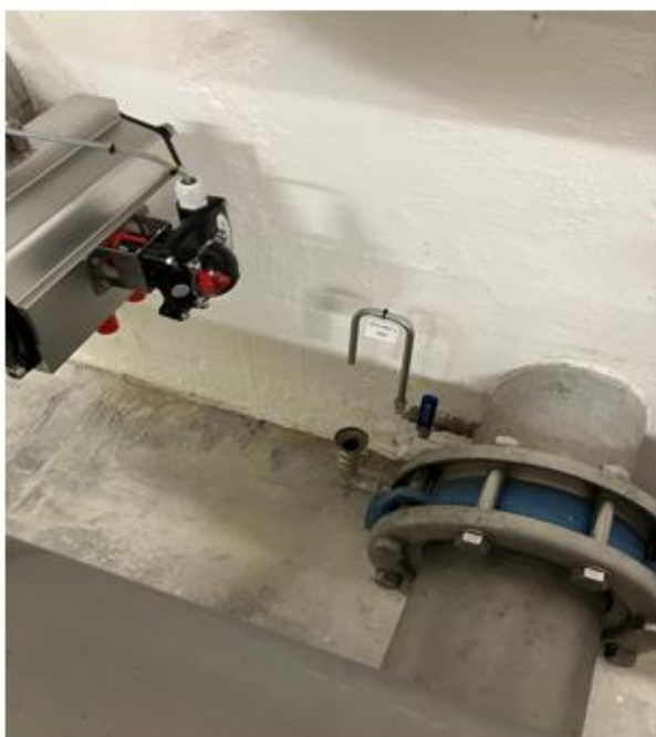
Figur 3 – Prøvehane efter filter
