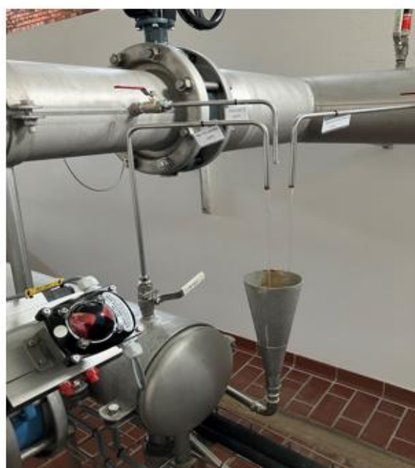
Figur 6 – Prøvehane før og efter UV-anlæg
