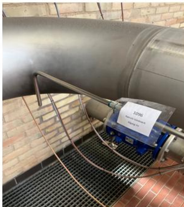
Figur 2 – Taphane afgang vandværk
