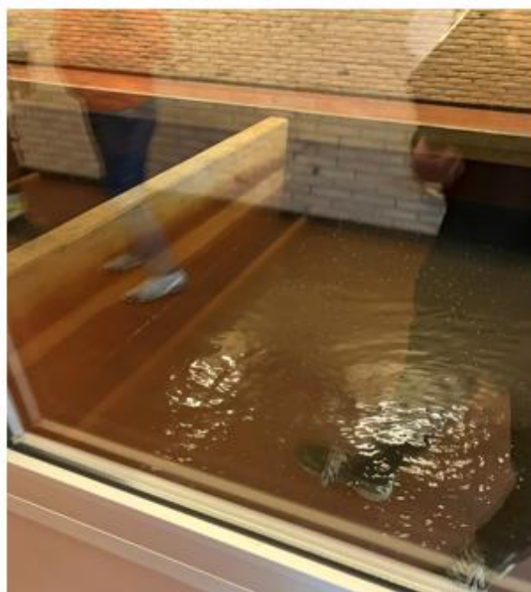
Figur 6 – Åben sandfiltre
