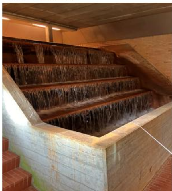
Figur 7 – Iltningsstrappe
