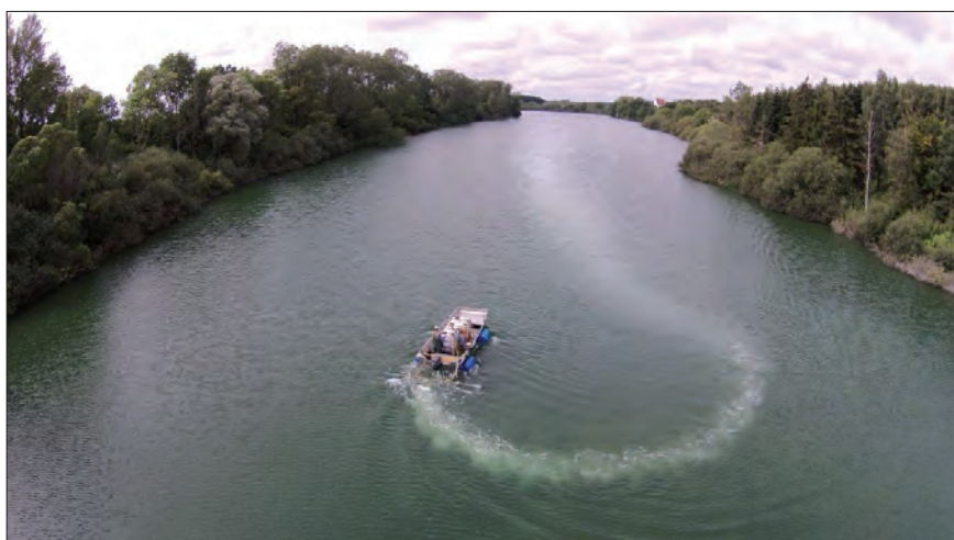
Figur 1. Udbringning af aluminium i Sørup Sø, Svendborg 2015. Bemærk den tydelige fane af udfældet \text{Al}(\text{OH})_3 efter båden. Foto Nils Mogensen Svalebø, Fyns Amtsavis.
