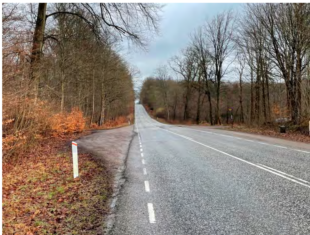
Figur 11-10. Foto fra st. 2 +200. Aktuelle forhold.
