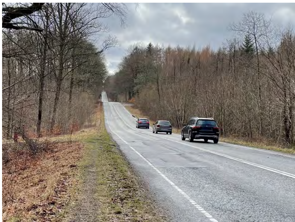
Figur 11-8. Foto fra st. 1 +750. Aktuelle forhold.
