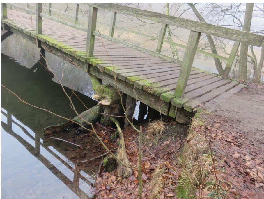
Figur 17: Overgang bro / terræn – SV brohjørne.
