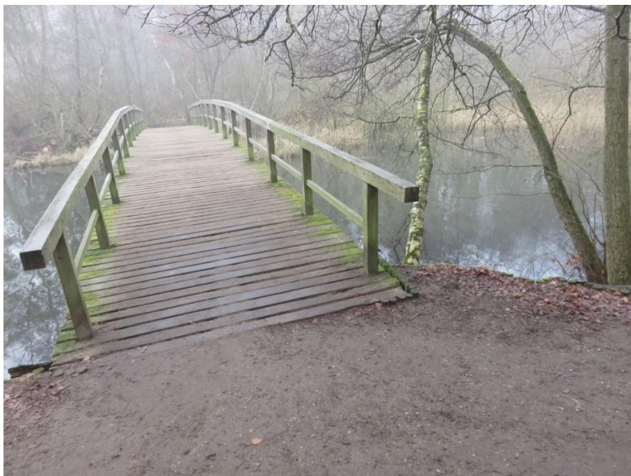
Figur 16: Overført passage – set fra syd mod nord.
