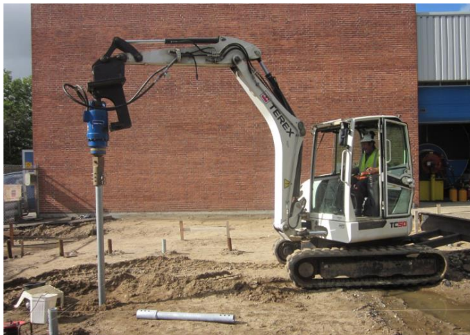
Figur 5: Installation af skruepæle.
