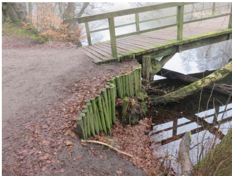
Figur 7: Eksisterende støttevæg i brohjørne for at holde på sti/bred.
