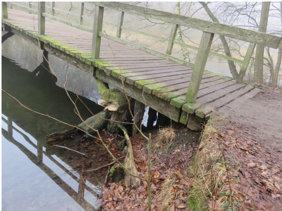
Figur 17: Overgang bro / terræn – SV brohjørne.
