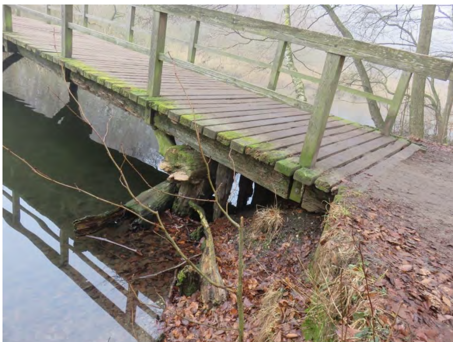
Figur 17: Overgang bro / terræn – SV brohjørne.
