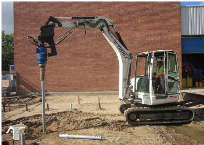
Figur 5: Installation af skruepæle.
