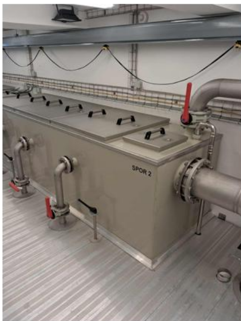
Figur 1: Lukket iltningsanlæg
