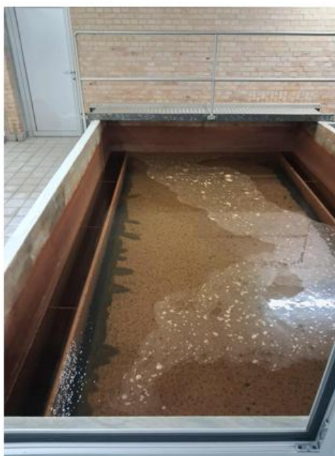
Figur 4: Åbent sandfilteranlæg
