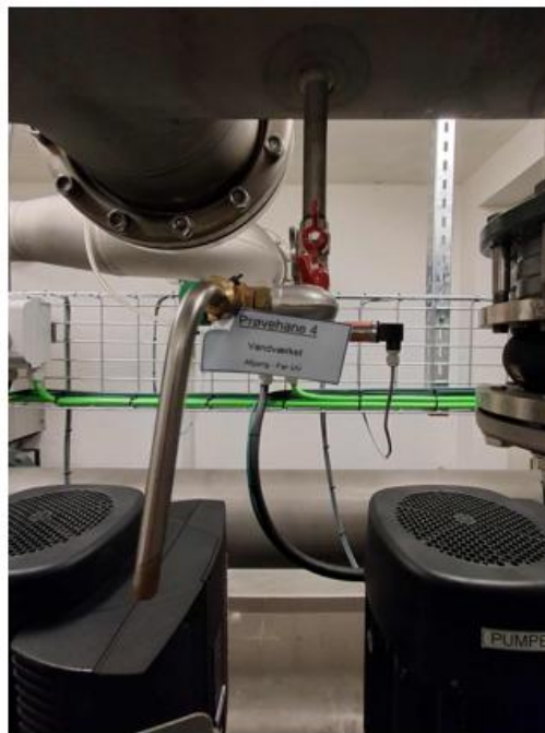
Figur 6: Prøvehane – afgang før UV
