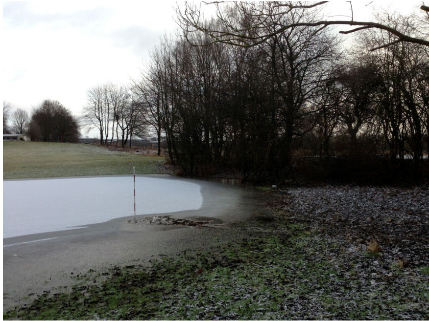
Figur 9. Billede taget d. 5/2-2013 af den sydvestlige del af 'Sletten'. Nedsivningsanlægget skal placeres ved landmålerstokken. I baggrunden ses forhøjningen hvori et kloakrør løber. Overløb sker over kloakrøret.
