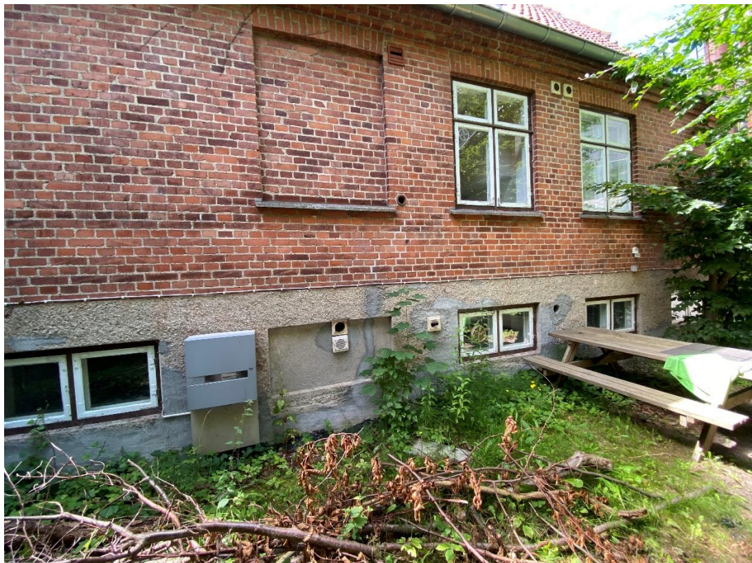
Figur 7: Ydersiden af huset (øst).
