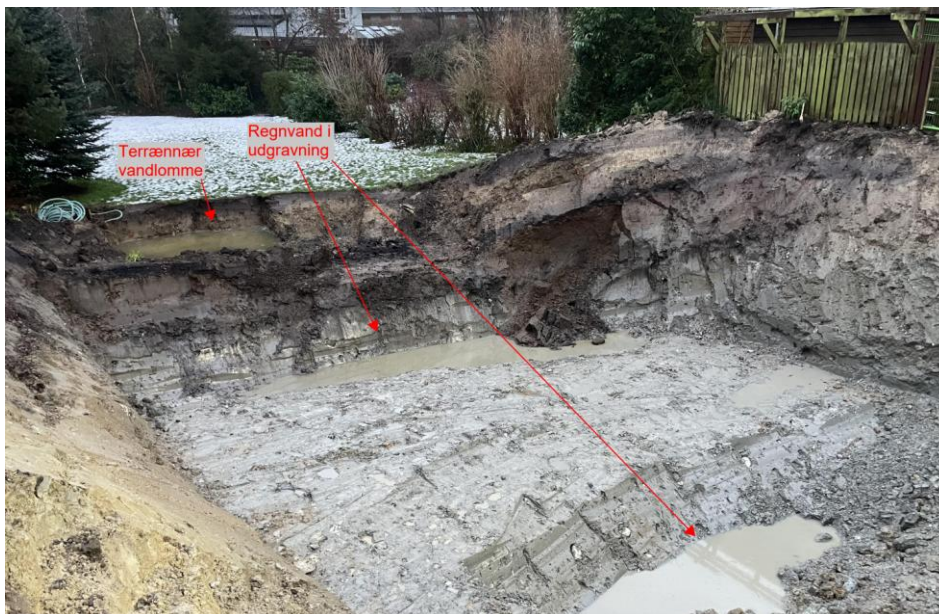
Figur 2 Foto af udgravning.
