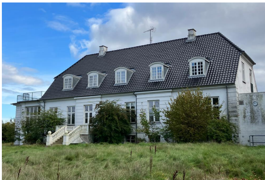
Figur 15. Foto der viser bygningens detaljer. På billedet ses hoveddørens trappe med balustre, der er tilpasset bygningens arkitektur.
