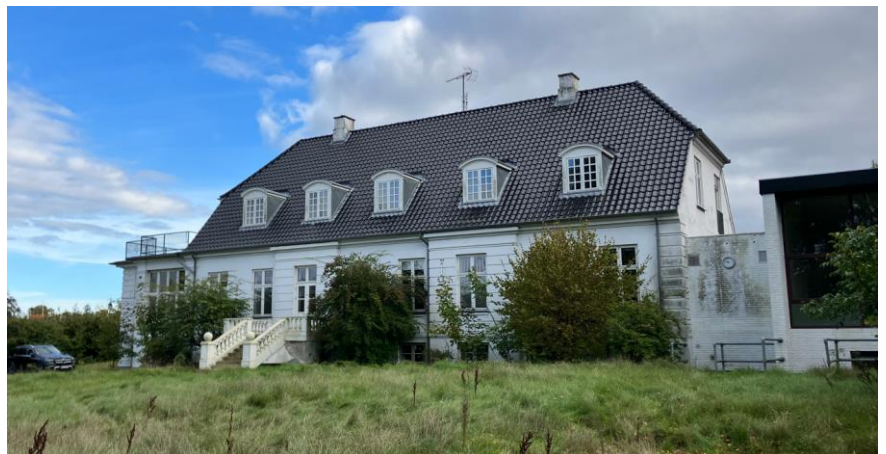
Figur 5 Eksisterende hovedbygning facade mod Vejlesøvej.
