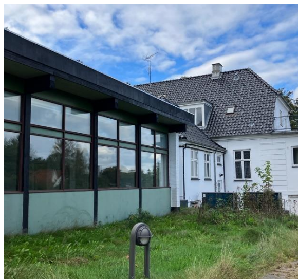
Figur 6 Eksisterende sammensatte bebyggelse.
