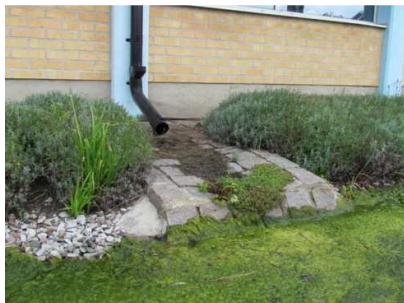
Figur 1: Regnvand ledes i en tæt rende bort fra huset til nedsivning i græsplænen. Augustenborg, Malmø. Foto Orbicon.
