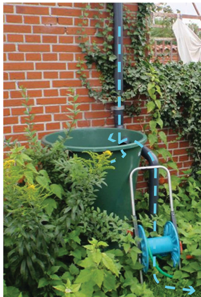
Figur 7: Tagvandet ledes via nedløbsrøret til regnvandstønden. Når tønden er fuld, ledes vandet i overløb til et andet nedsvingselement i haven. Tønder fås i flere varianter, og kan som i dette tilfælde skjules af beplantning. Slagslunde, Egedal Kommune. Foto Orbicon.
