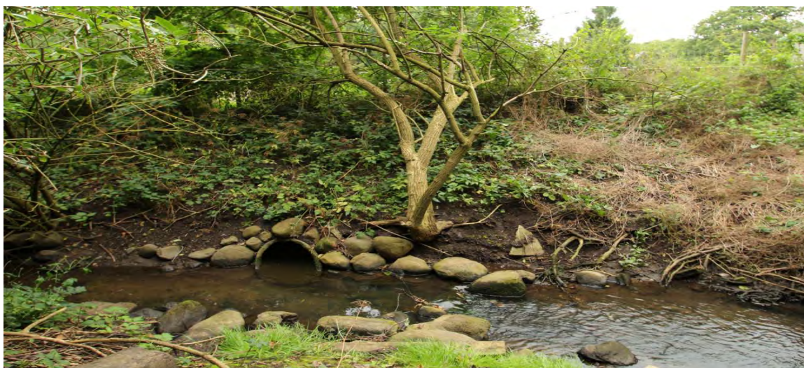
Illustration 5.1 Overløb fra Rundforbi Renseanlæg til Kikhanerenden.
