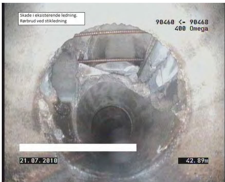
Illustration 3.6 TV-inspektion af ledning.
